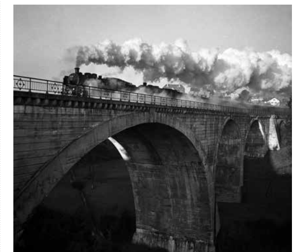
Eine bautechnische Herausforderung war die Überquerung der Iller in Kempten. Eine Lok der legendären bayerischen Gattung S 3/6 und eine 39 führten um 1953 einen Schnellzug über die majestätische Brücke.
