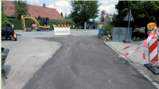
Wichtige Baumaßnahme am Holzkirchner Weg wurde fertiggestellt
